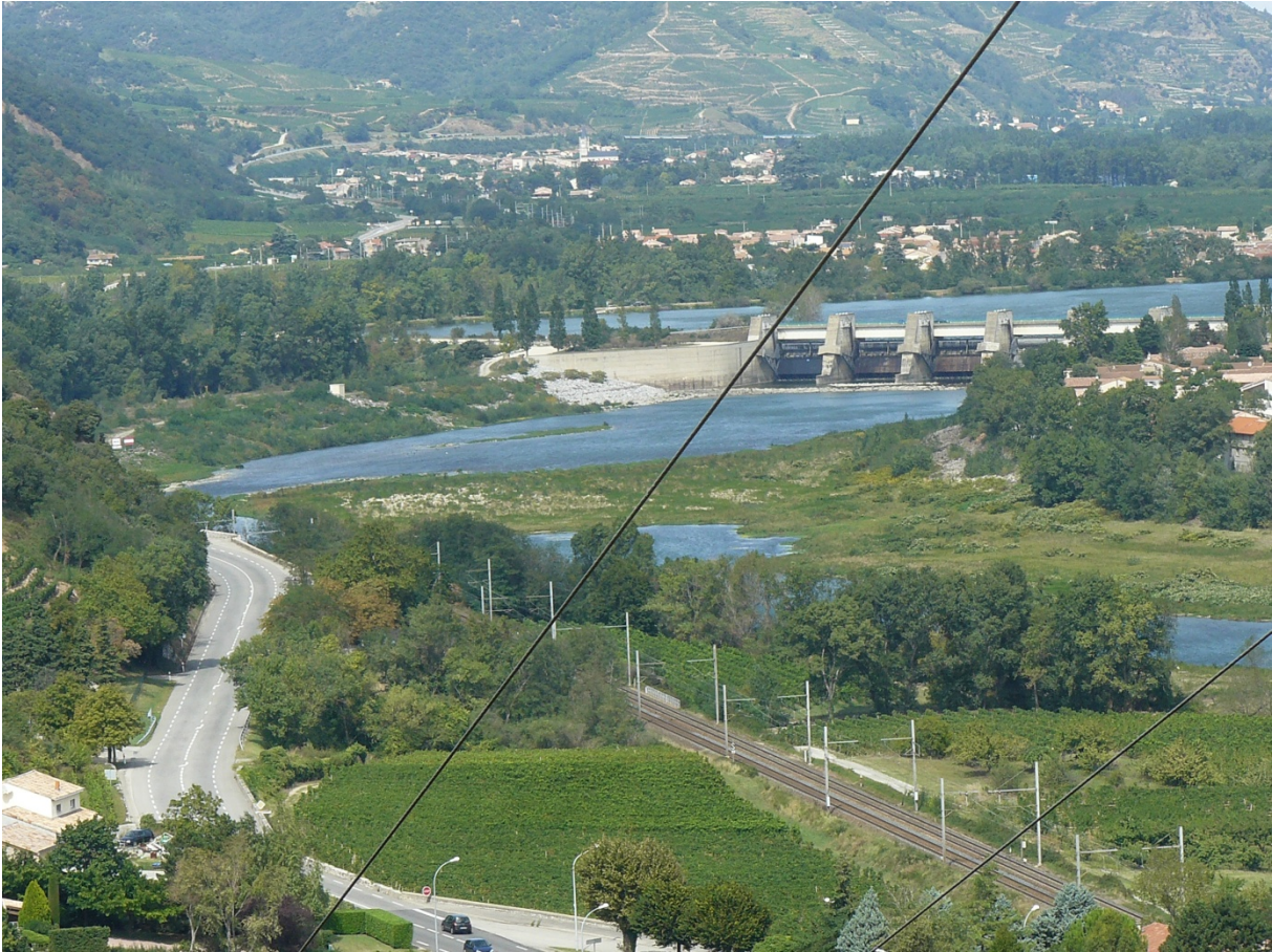
Figure 23 : Vieux Rhône de Bourg-Lès-Valence, rive droite, vue en direction de l'amont (Gaydou, le 22.07.08)
