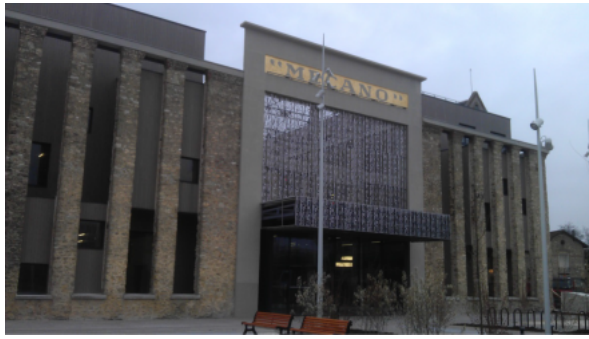
2 L'usine Mécano (La Courneuve) transformée en médiathèque communautaire
