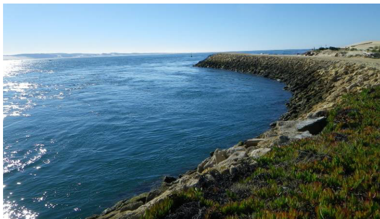
FIG. 2 – Photographie représentative des ouvrages de protection
