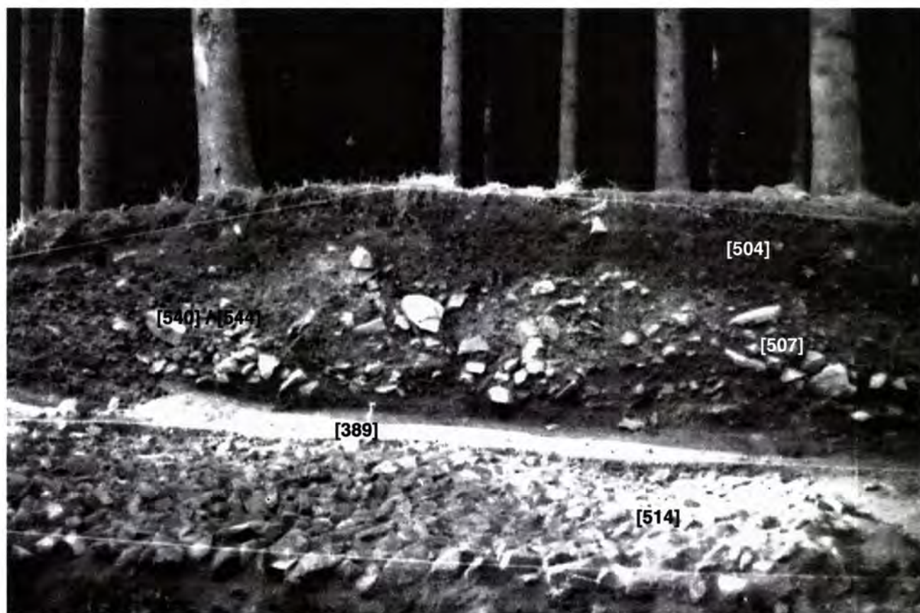
82. Le bastion sud : coupe dans les structures des phases 8 sud et 9 sud.
