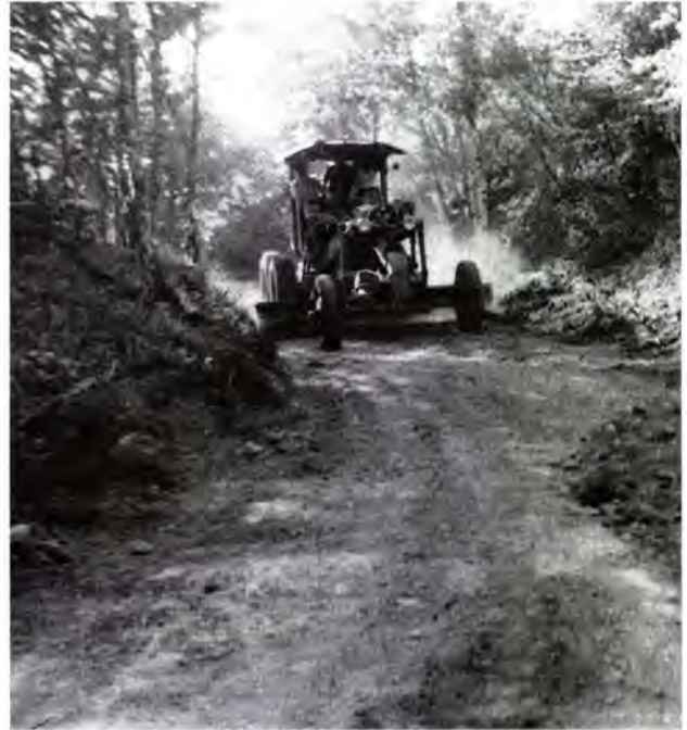
9. Le bastion sud de la Porte du Rebout coupé lors des travaux de 1959. (Collection particulière.)
