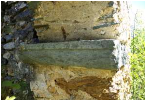
Fig. 4 (à gauche, en haut) : Une des corniches d'angle à la jonction du mur de chevet et du mur est
