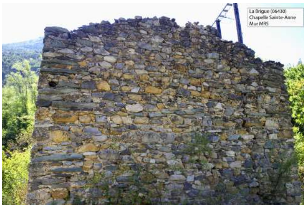
Fig. 2 : Parement de l'extérieur du mur de chevet
