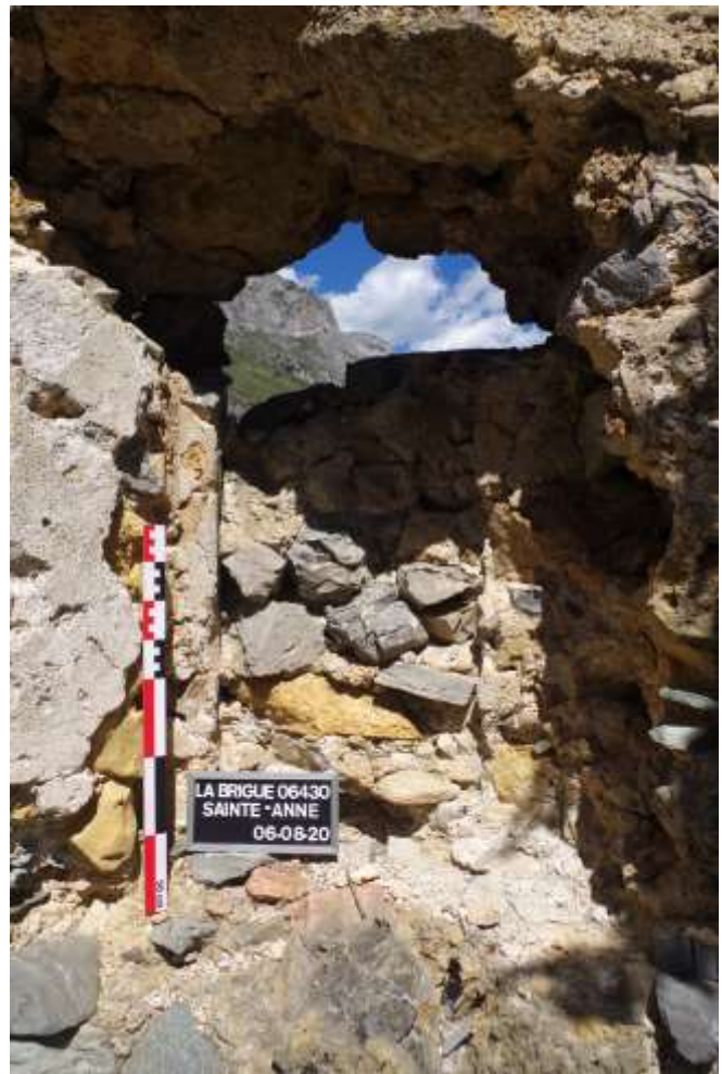
Fig. 4 (à gauche, en haut) : Une des corniches d'angle à la jonction du mur de chevet et du mur est
