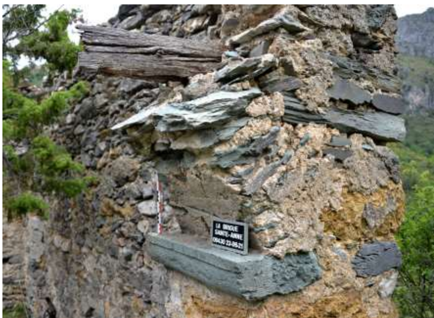
Fig. 8 : Tirant T1-2 vu de l'extérieur
