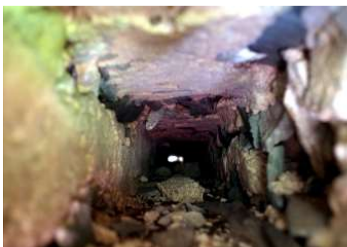
Fig. 10 : Négatif du tirant du mur ouest vu du conduit
