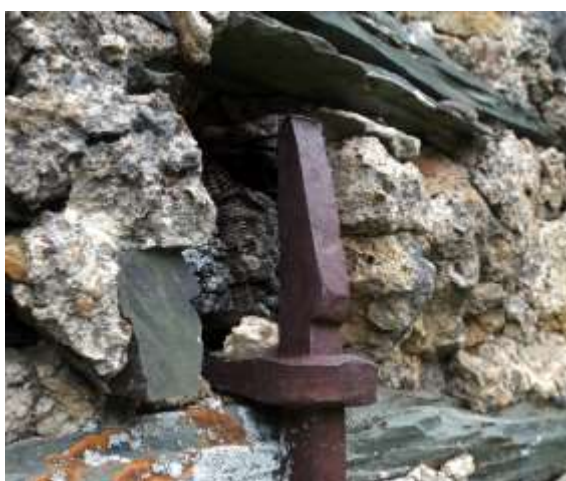
Fig. 9 : Ancre placée dans le conduit du tirant T7-8 à son extrémité est
