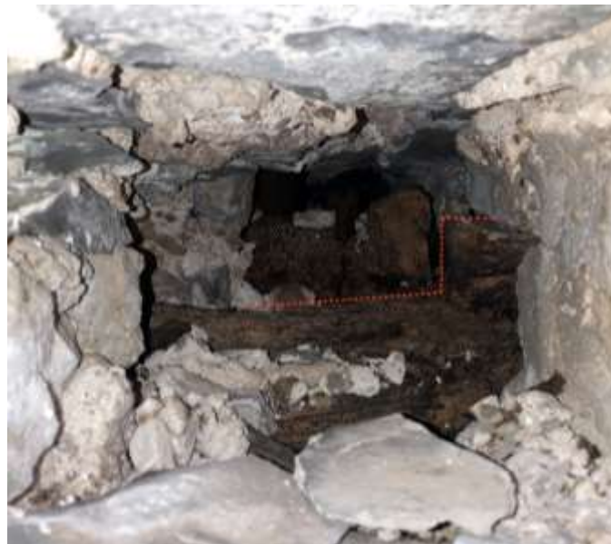
Fig. 18 : Conduit du tirant T7-8 au niveau de la jonction avec le tirant T1-2 ; en orange, l'une des encoches du tirant T1-2 qui permettait aux deux pièces de s'emboîter
