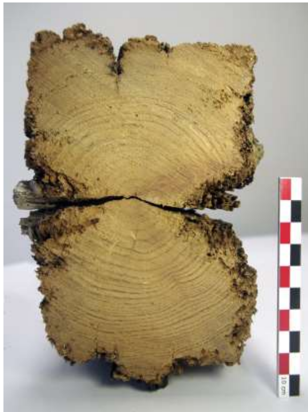
Fig. 14 : Partie découpée du tirant T1-2
