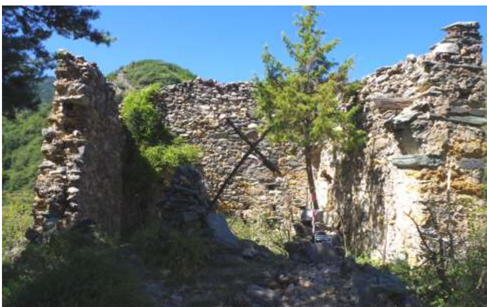
Fig. 3 : Vue générale des ruines de la chapelle
