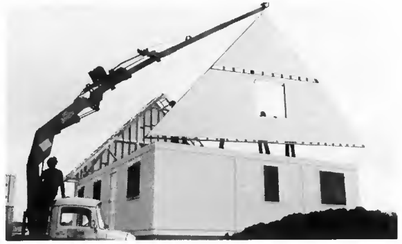
LA MAISON MODULAIRE. La mise en place est rapide, mais exige une grue puissante.
