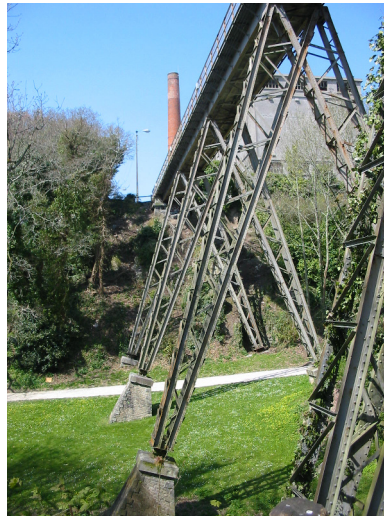
FIG. 1 – Le viaduc de Lambézellec.
