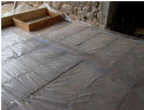
FIG. 1 – Plancher mixte bois-béton.
