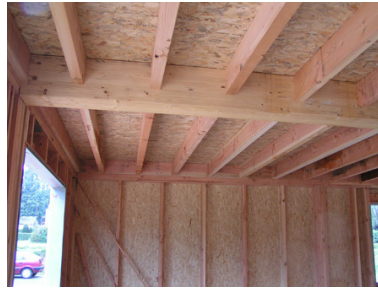
FIGURE 1 – Structure à ossature bois - plancher et mur
