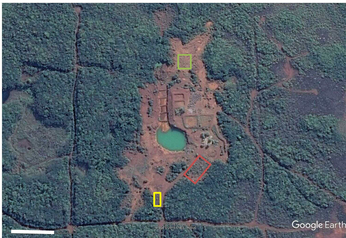
Figure 64 : Localisation des sites revégétalisés A1 (encadré jaune), A2 (encadré rouge) et A3 (encadré vert) sur la zone de l'Ancienne pépinière.
