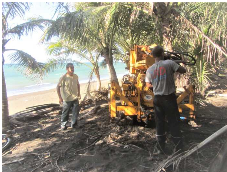
Figure 15 : Les opérations de mise en station de la foreuse (Sédidrill) et l'équipe de forage de l'IRD en haut de plage sur le point de forage S2.
