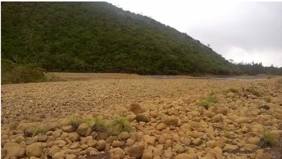
Figure 112 : Dépôts en amont de la digue routière sur la Todré
