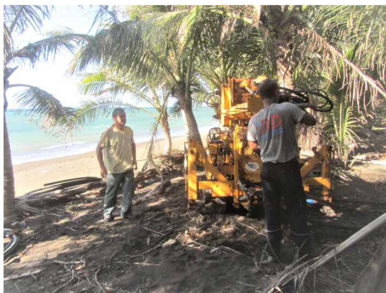
Figure 15 : Les opérations de mise en station de la foreuse (Sédidrill) et l'équipe de forage de l'IRD en haut de plage sur le point de forage S2.
