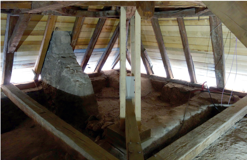
Fig. 4. Vestiges maçonnés de la tour dans les combles du couvent (Cliché : S. Bochaton).
