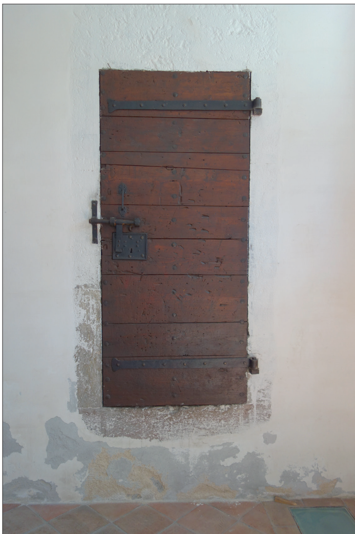
Fig. 6. Porte de l'ancienne cellule du rez-de-chaussée de la tour des prisons (Cliché : S. Bochaton).
