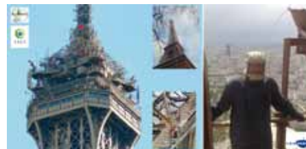
Installation de la station CO 2 -MEGAPARIS de suivi de la concentration du CO 2 de Paris au sommet de la tour Eiffel, en collaboration avec AIRPARIF (juillet 2010). Le point rouge indique le niveau de prélèvement, environ 10 m au-dessus du troisième étage ouvert aux touristes. Pour y accéder, le technicien doit se protéger des rayonnements émis par les antennes.
