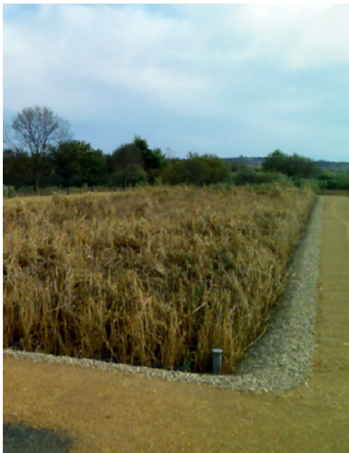
Traitement des eaux polluées dans les bassins plantés de macrophytes © : Pierre Caumette
