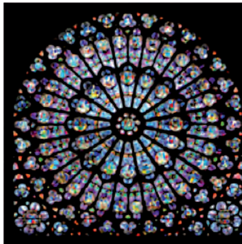
Les couleurs de ce vitrail sont dues à l'incorporation de nanoparticules d'or dans le verre.
