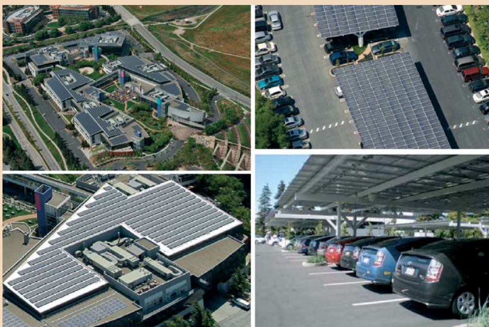
Le campus Google à Mountain View en Californie avec son installation photovoltaïque de 1,6 MW et sa flotte de véhicules hybrides rechargeables.
