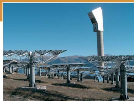
Centrale électrique solaire pilote de Thémis (Pyrénées Orientales) où sera testé le stockage à base de céramiques issues du traitement de déchets amiantés.
