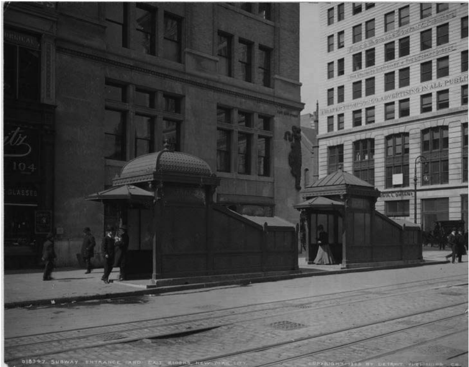
Fig. 5 – Kiosque d'entrée et de sortie du Subway, New York City, 1905.
