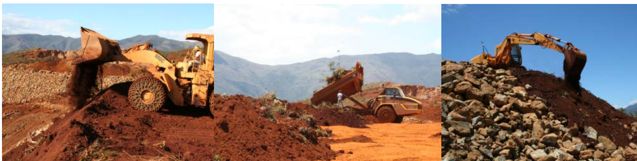
Figure 19 : Approvisionnement en topsoil et épandage sur zone.
