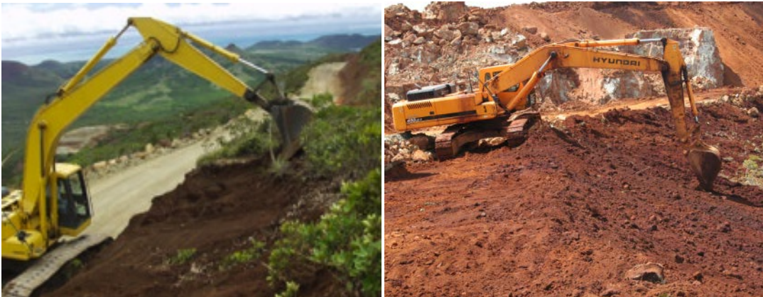
Figure 12 : Récupération de topsoil sur les zones pentues par le bas et par le haut.
