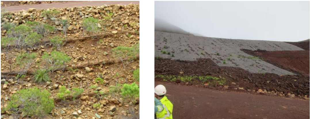
Figure 16 : Techniques de stabilisation des sols par utilisation de fascines (©SIRAS) ou géofilet (©UNC-IAC).
