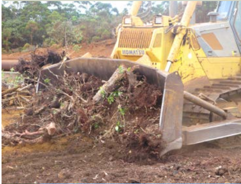
Figure 11 : Illustrations des étapes de défrichage, mise en andain et chargement des substrats récupérés lors du décapage (topsoil).
