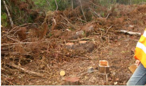
Figure 11 : Illustrations des étapes de défrichage, mise en andain et chargement des substrats récupérés lors du décapage (topsoil).
