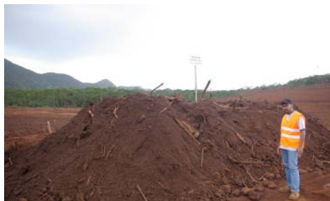
Figure 14 : Topsoil en andain (2 m de haut environ) ou étalé, stocké sur la mine de VALE à Goro (mise en place août 2011) ©iac.
