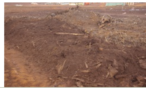
Figure 14 : Topsoil en andain (2 m de haut environ) ou étalé, stocké sur la mine de VALE à Goro (mise en place août 2011) ©iac.
