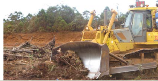
Figure 11 : Illustrations des étapes de défrichage, mise en andain et chargement des substrats récupérés lors du décapage (topsoil).
