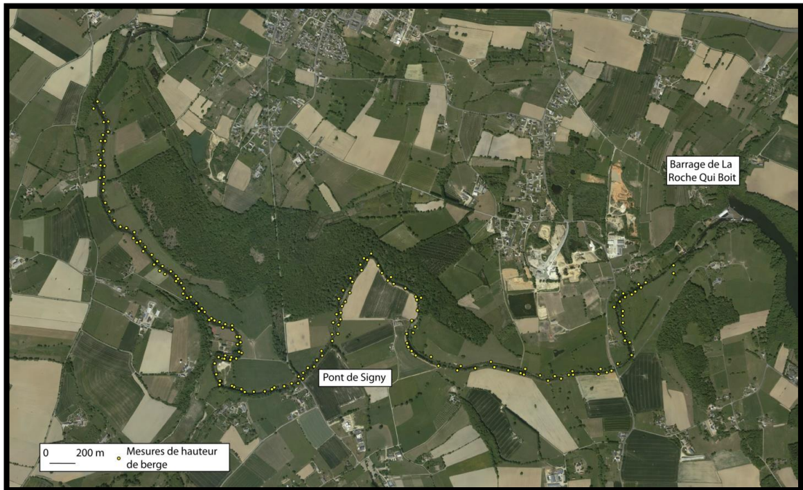
Figure 4 : Points de mesure des hauteurs de berge (juillet 2015)
