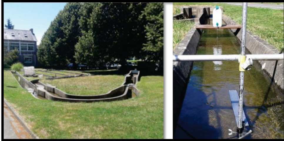
Figure 24 : Canal de l'Agrocampus de Rennes et installation de l'UB-Flow sur la section droite du canal
