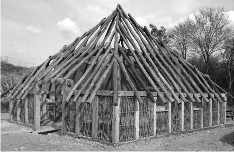
Fig. 4. Reconstitution du bâtiment à module porteur de Glisy (Parc de Samara, cliché Ludovic Moignet)
