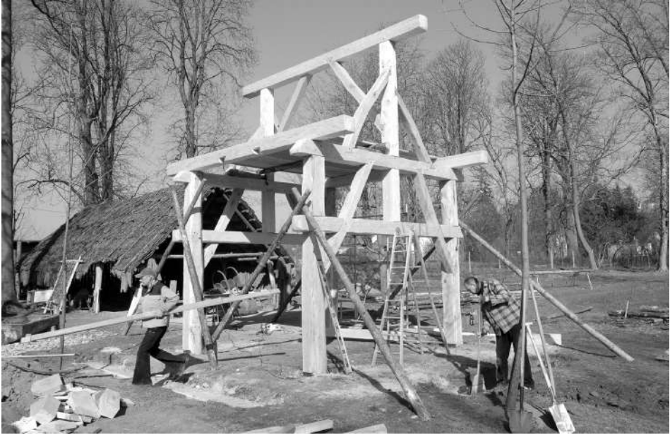
Fig. 7. Reconstitution du bâtiment à module porteur de Michelstetten, en cours de construction (Musée du MAMUZ, cliché Rolf Palm)
