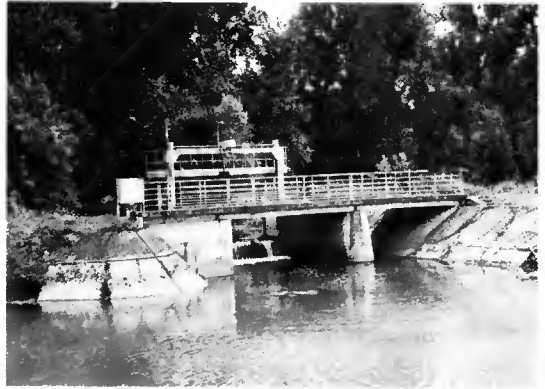
▲ Barrage et écluse de la Sotterie sur la Sèvre Niortaise
