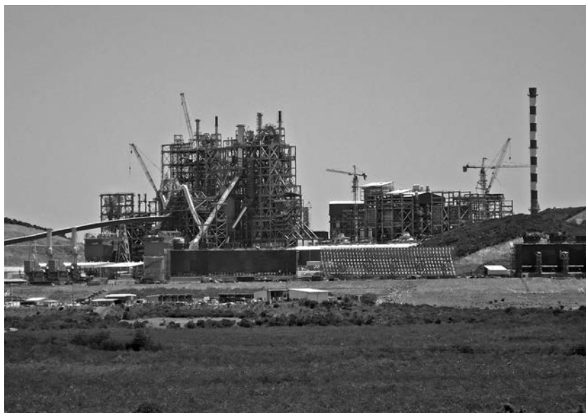
L'usine en construction en 2012, vue du bar de la base-vie. © C. Salomon
