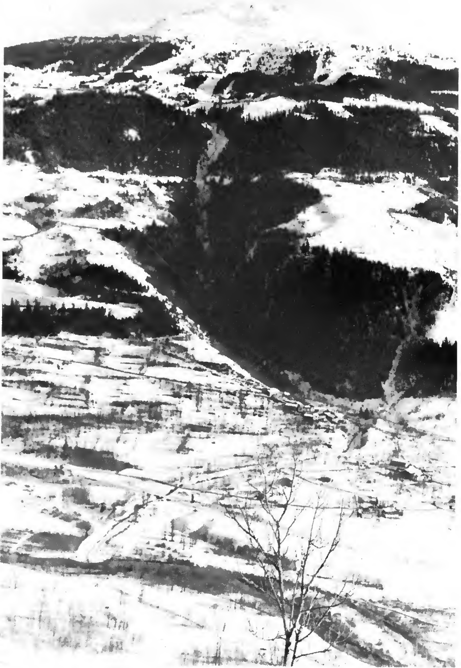
Vue d'ensemble du bassin du ruisseau de la Ravoire et du domaine skiable d'Arcs 1600 à Bourg-Saint-Maurice (73) révélant l'étendue des défrichements pour pistes et la transformation du ruisseau en torrent par affouillement et effondrement des berges boisées. Au bas de la photo, le hameau de la Ravoire et la voie ferrée sont menacés chaque été par des laves torrentielles depuis 1973.
