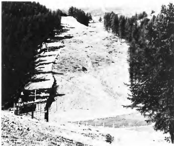
Piste à ski défrichée et nivelée au buteur dans les mélèzes supérieurs de Serre-Chevalier (05) La partie inférieure subhorizontale est un remblai dont le réengazonnement récent a été provisoirement protégé du pâturage par une clôture.
