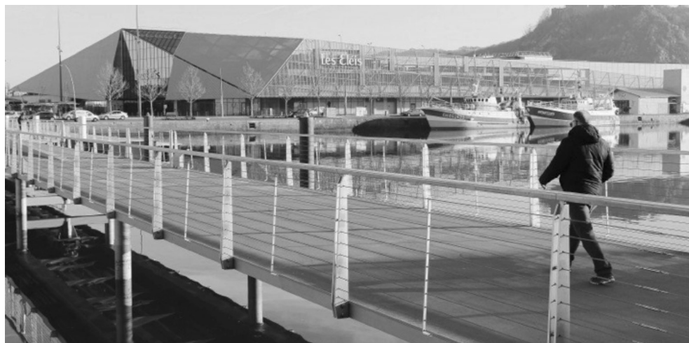
Figure 3 : Le centre commercial bordant le bassin de commerce et au premier plan la passerelle relevable
