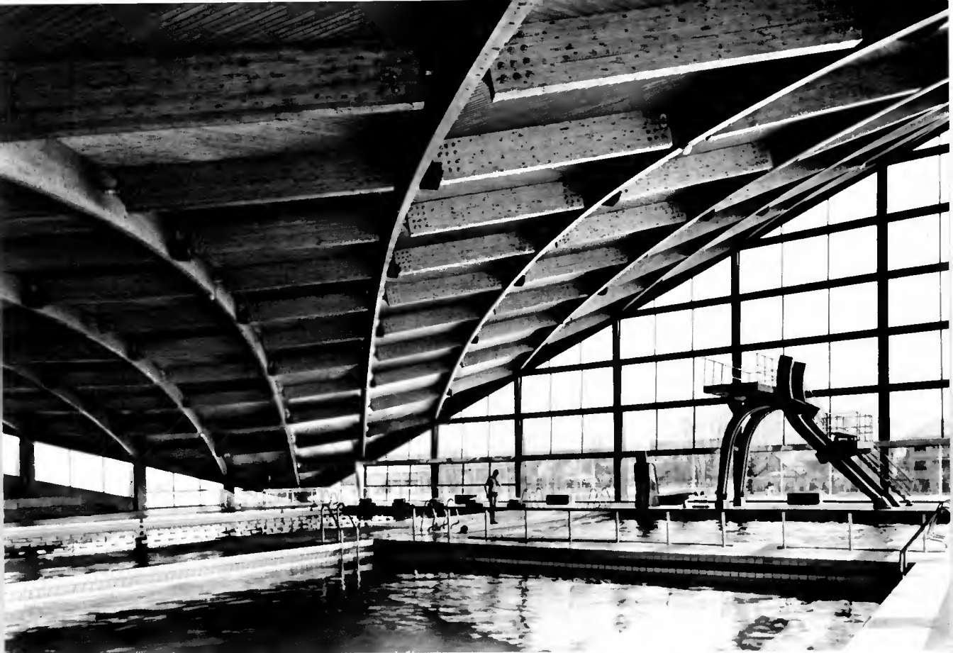
Charpente lamellée-collée. Piscine d'Aulnay-sous-Bois
