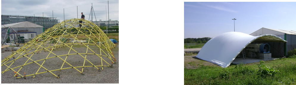
FIG. 3 – Premiers prototypes de Grid Shells en matériaux composites
