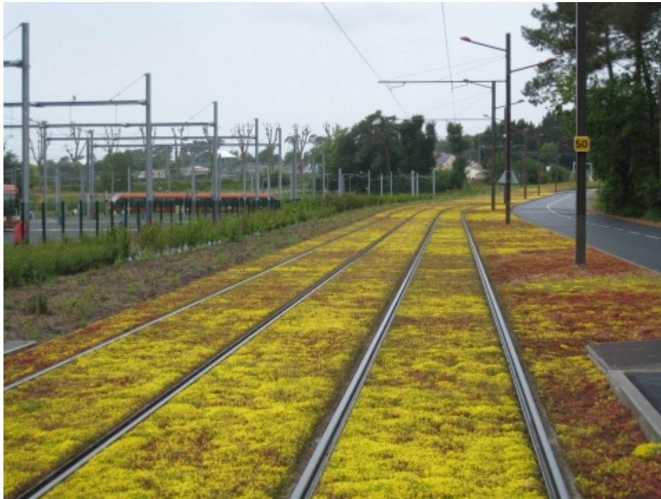
Figure 4. Verdissage des voies de tram à Montpellier : le sedum, plante grasse, près du dépôt Le Mans
