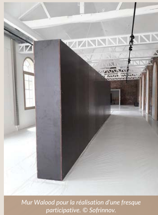
Construction d'un mur à Ramonville-Saint-Agne (31). © Sofrinnov.
