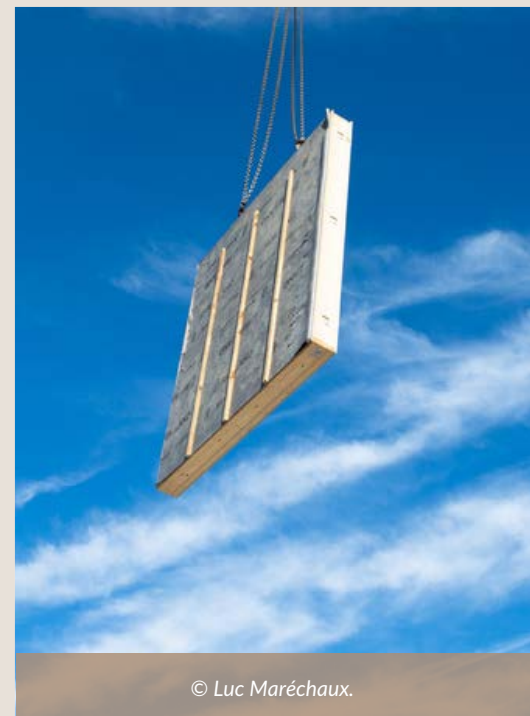
Chantier de bureaux à Clamart (92). © Luc Maréchaux.
