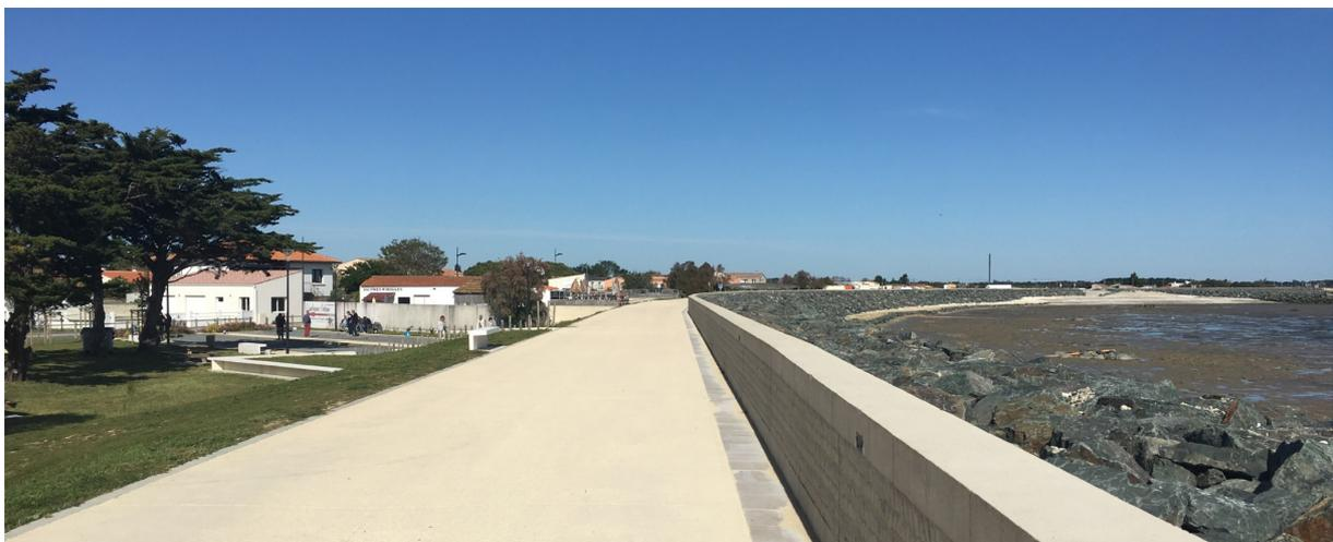
Figure 3 : Les zones basses de l'agglomération rochelaise sont désormais protégées par un système d'endigement continu. Un foncier maintenu « sous cloche » ? Source : photographie de l'auteur.
