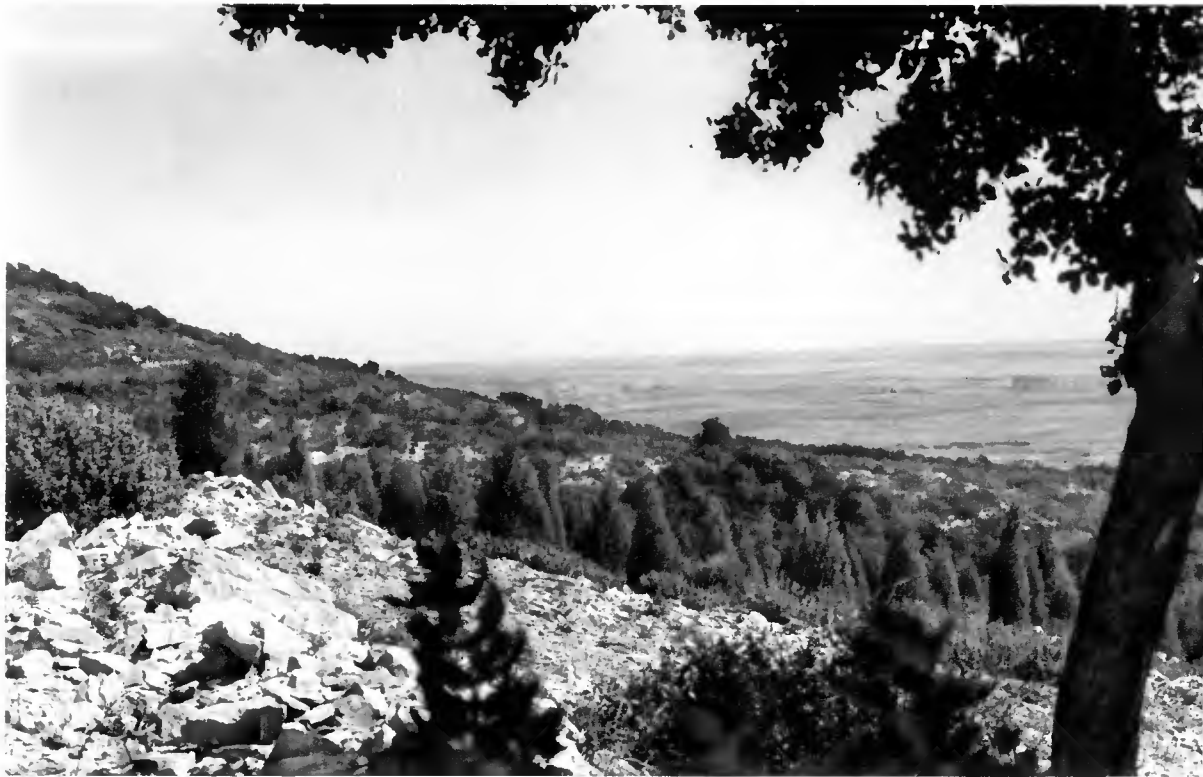
Périmètre de Vic-la-Gardiolo : partie basse du chantier
