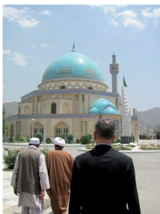
Fig.9 - La mosquée de l'ayatollah Mohseni, dite Mosquée bleue, à Kaboul*
