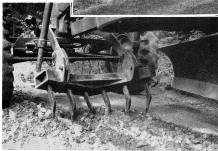
Travail des griffes du Motorgrader sur empierrement usé.
