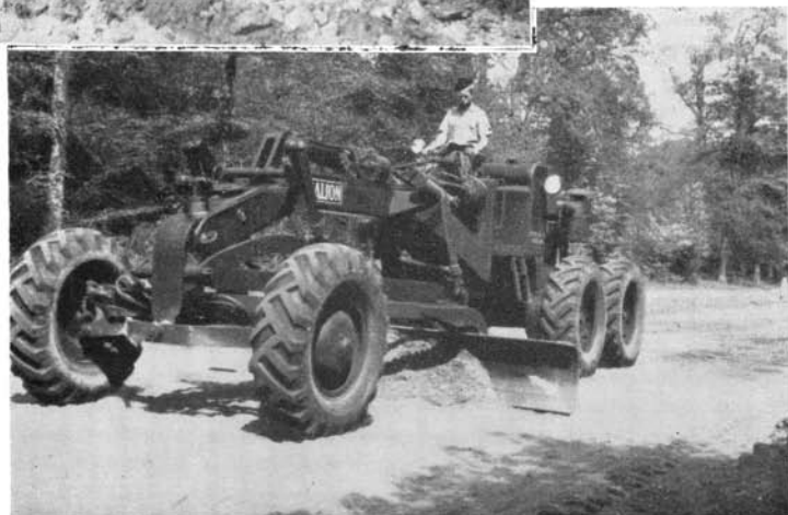
Remise en forme d'un chemin de terre au Motorgrader.
