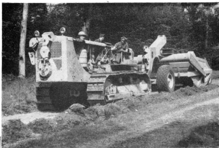
Décapage d'un chemin de terre au Scraper.
