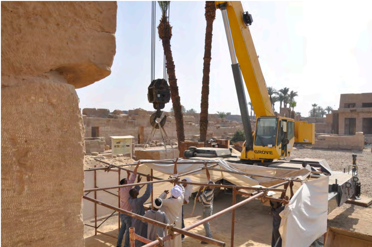
Fig. 14. Enlèvement des blocs à la grue.
