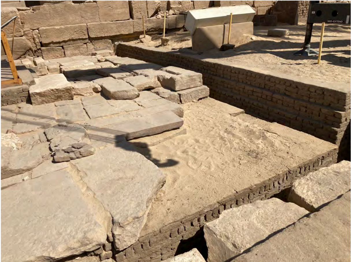
Fig. 64. Commencement de la remise en place des dalles de fondation restaurées
