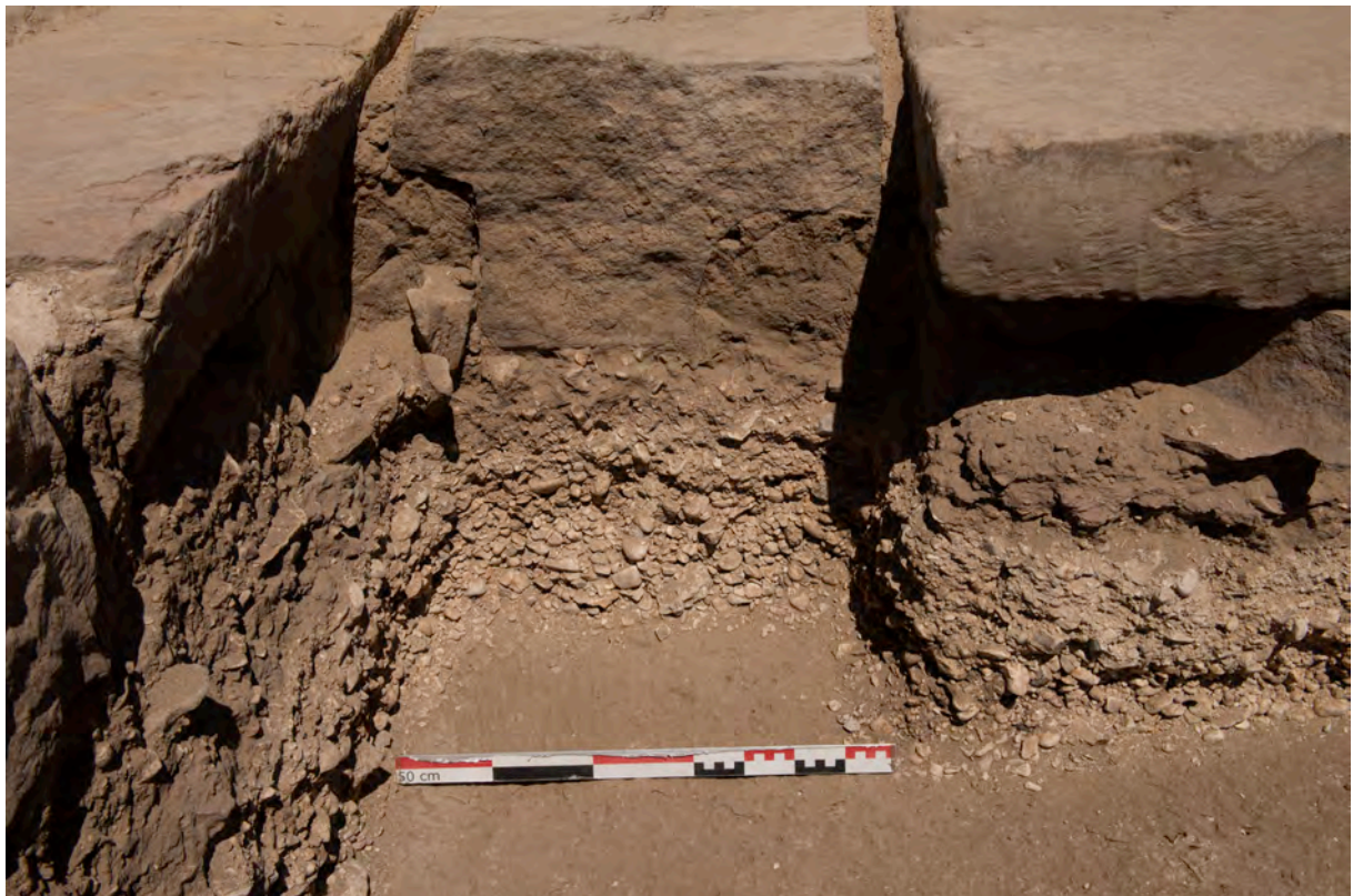
Fig. 16. Le bloc de corniche remployé, partie non extraite.
