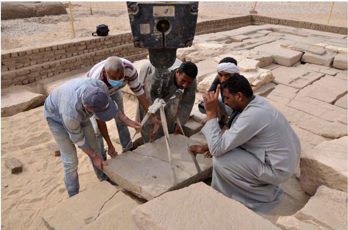
Fig. 33. Le remontage de la plate-forme avec la remise en place des blocs extraits puis restaurés.
