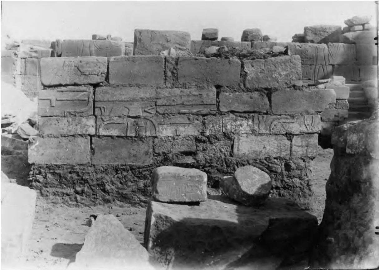
Fig. 57. Les vestiges du monastère byzantin dans la cour du VIII e pylône employant des blocs kouchitee, avant leur démontage par M. Pillet. On note l'absence de dispositifs de fondation visible.
