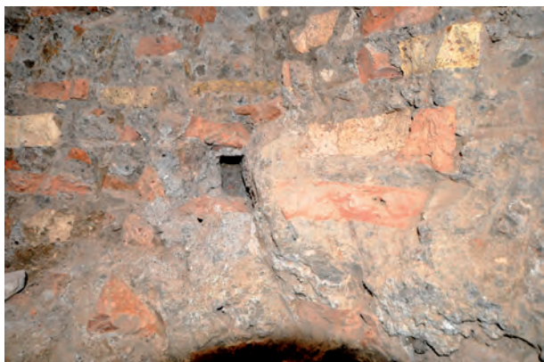
19 – ROMA, PALATINO, AREA DELLA VIGNA BARBERINI IMPRONTA DI UN ELEMENTO A SEZIONE RETTANGOLARE (3×7 CM) CHE ERA STATO FISSATO ALL'INTERNO DELLA MURATURA DI ETÀ NERONIANA SUL TRATTO CORRISPONDENTE AL MURO ANULARE
