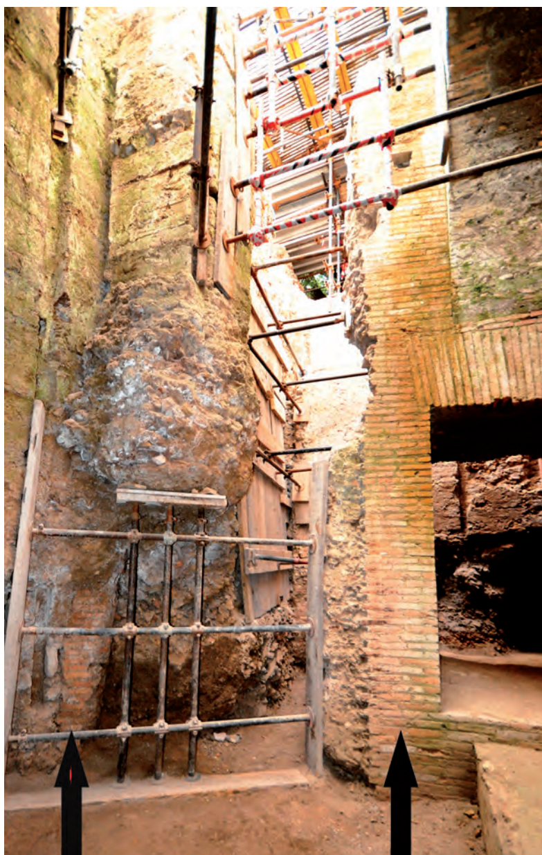
17 – ROMA, PALATINO, AREA DELLA VIGNA BARBERINI RESTI DEL PARAMENTO INTERNO DEL MURO ANULARE DI ETÀ NERONIANA, AI LATI DEL TAGLIO VERTICALE PRATICATO IN CORRISPONDENZA DELL'APPENDICE MERIDIONALE
