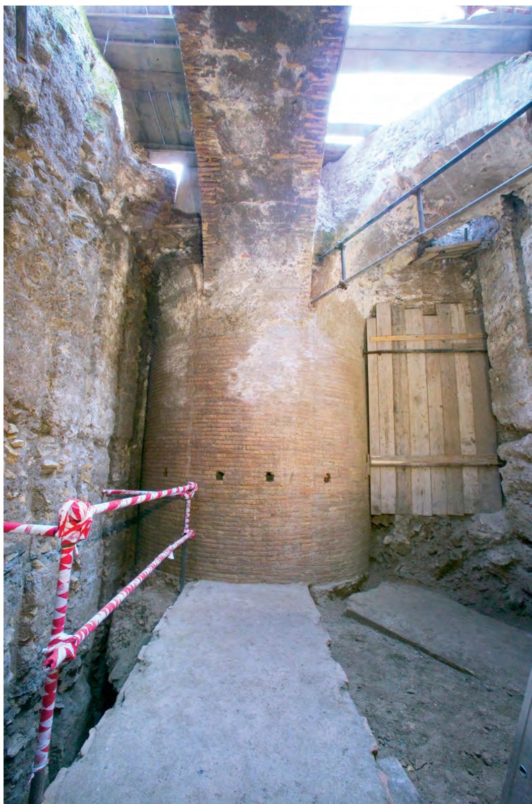
10 – ROMA, PALATINO, AREA DELLA VIGNA BARBERINI IL PILONE CENTRALE E GLI ARCHI A TUTTO SESTO CHE LO COLLEGANO AL MURO ANULARE Sono visibili gli archi alla sommità della struttura e altri, ubicati 6 m sotto, al livello del primo piano.
