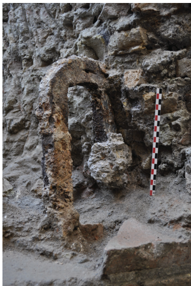
FIG. 8. – Objet en fer portant le nom de cavalier qui a été laissé en place en marge du massif D. Au cours de la démolition, il a probablement été masqué par des gravats et il a ainsi échappé à l'opération de récupération (cliché Ch. Durand, AMU-CCJ/CNRS ; vue orientée vers l'est).
