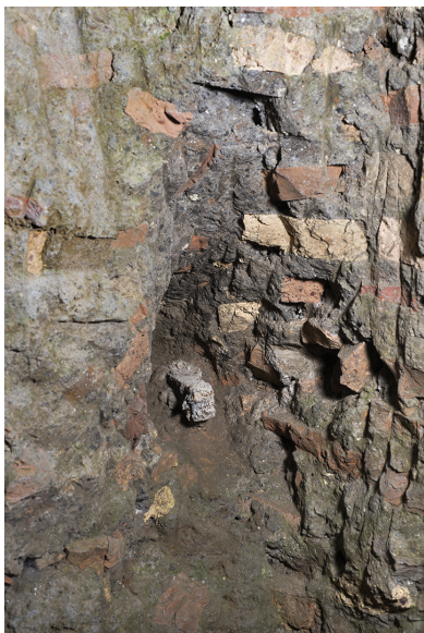
FIG. 7. – Fragment resté en place d'une barre de fer qui a été brisée. On note tout autour les empreintes des pointes des pioches utilisées pour creuser le blocage et dégager l'extrémité de la barre (cliché Ch. Durand, AMU-CCJ/CNRS ; vue orientée vers l'est).
