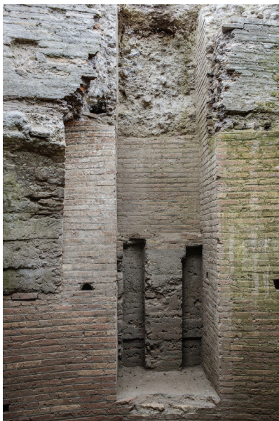
FIG. 10. – Renforcement destiné au logement d'un dispositif technique aménagé dans le mur B (cliché Ch. Durand, AMU-CCJ/CNRS ; vue orientée vers le nord).
