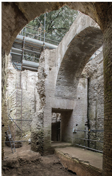
FIG. 9. – Vue prise du nord vers le sud, à l'intérieur de l'espace circonscrit par le mur B. À droite apparaît une partie du pilier et, au fond, sur la gauche, la faille correspondant au démantèlement du massif D, puis la baie ouverte dans le mur B. Au-delà de la baie est reconnaissable le reste de l'encadrement d'un aménagement technique, à tort identifié dans un premier temps à une fenêtre (cliché Ch. Durand, AMU-CCJ/CNRS).
