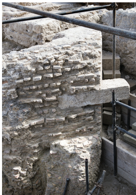
FIG. 6. – Tronçon du mur B dans lequel est inséré un gros bloc de travertin ayant vraisemblablement servi à supporter une charpente. Sur la tranche du même mur, la maçonnerie présente un aspect particulier, les briques apparaissant en ressaut par rapport au blocage : il s'agit de l'un des parements d'attente décrits plus loin (cliché Ch. Durand, AMU-CCJ/CNRS ; vue orientée vers l'est).
