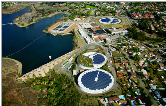
Figure 17. SunEdison : toit solaire d'Alvarado, USA ; puissance : 1,3 MWc.
