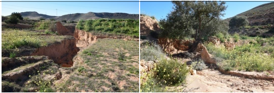
Figure 5. Echantre ouverte dans une tabia, prolifération du ravinement dans la surface d'un Jesr et déchaussement des implantations.
