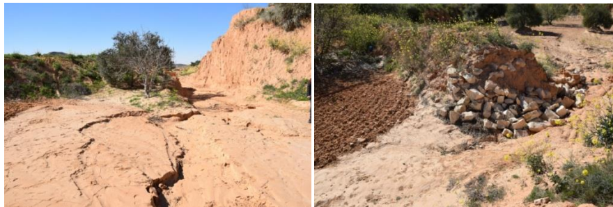
Figure 6. Alluvions colmatant partiellement la surface d'un Jesr et culée de pierres sèches démolie par le ruissellement détruisant le déversoir.
