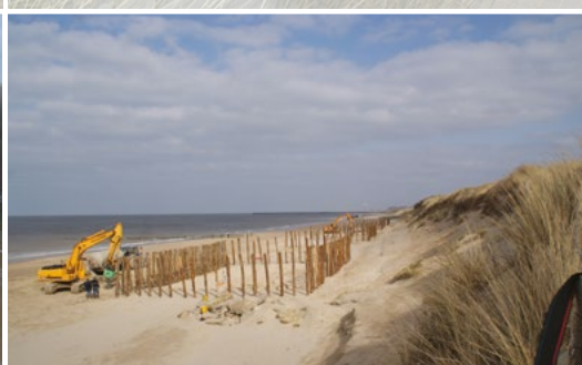
Mars 2010 - Installation de casiers brise-vent
