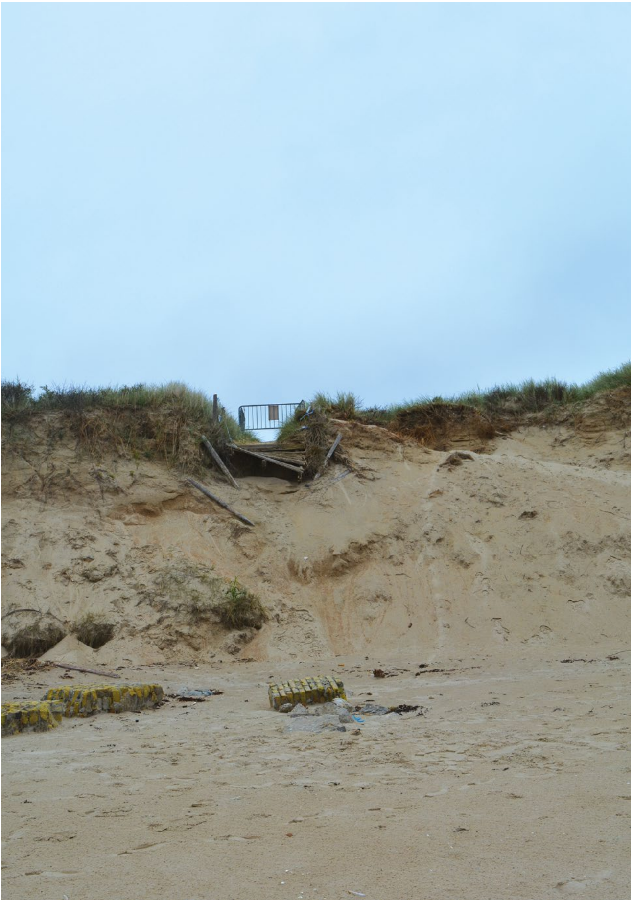
CI-DESSUS DESTRUCTION DE L'ESCALIER D'ACCÈS À LA PLAGE DU PLATIER D'OYE LORS D'UNE TEMPÊTE EN 2018 Cliché : M-H Ruz
