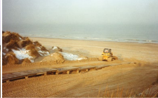
1994 - Aménagement d'un accès à la plage
