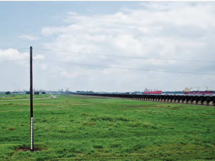
Terminée en 1931, après la grande crue de 1927, Bonnet Carré Spillway est un barrage filtrant de plus de 2 kilomètres de long qui agit comme une soupape réduisant la quantité d'eau du Mississippi en la canalisant dans le lac Pontchartrain. © Urbain, trop urbain
