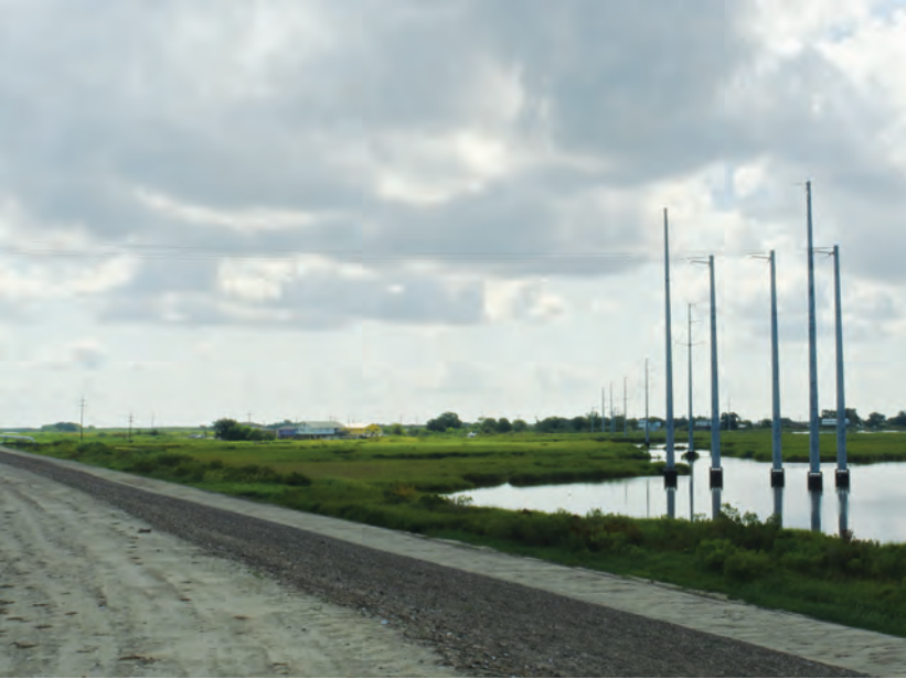
Nouvelle digue en construction le long du Bayou Lafourche, à Galliano, et nouveaux marais créés par diversion de sédiments. © Urbain, trop urbain
