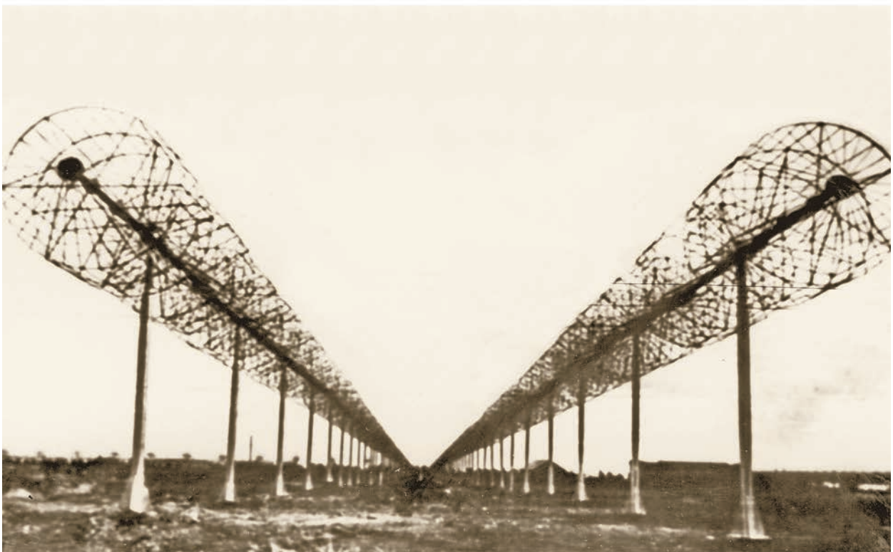
Рис. 4. Антени Північ–Південь і Схід–Захід радіотелескопа УТР-1 діапазону 10 ÷ 25 МГц – першого Т-подібного радіотелескопа у Європі
