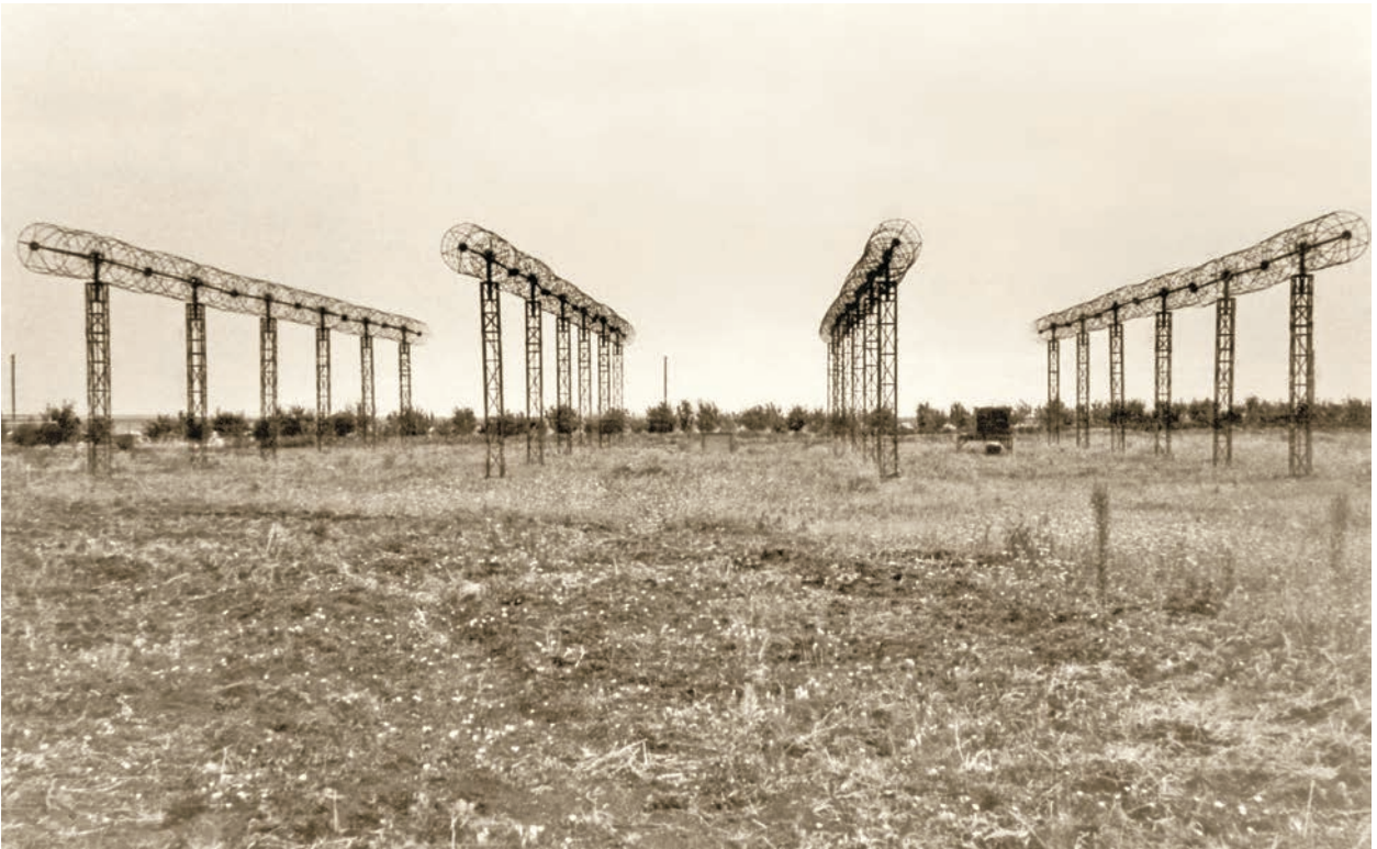
Рис. 2. Перший в Україні 24-елементний радіотелескоп декаметрових хвиль ID-1(2) діапазону 10 \div 25 МГц, споруджений в обсерваторії поблизу с. Гракове Харківської обл. на початку 60-х років
