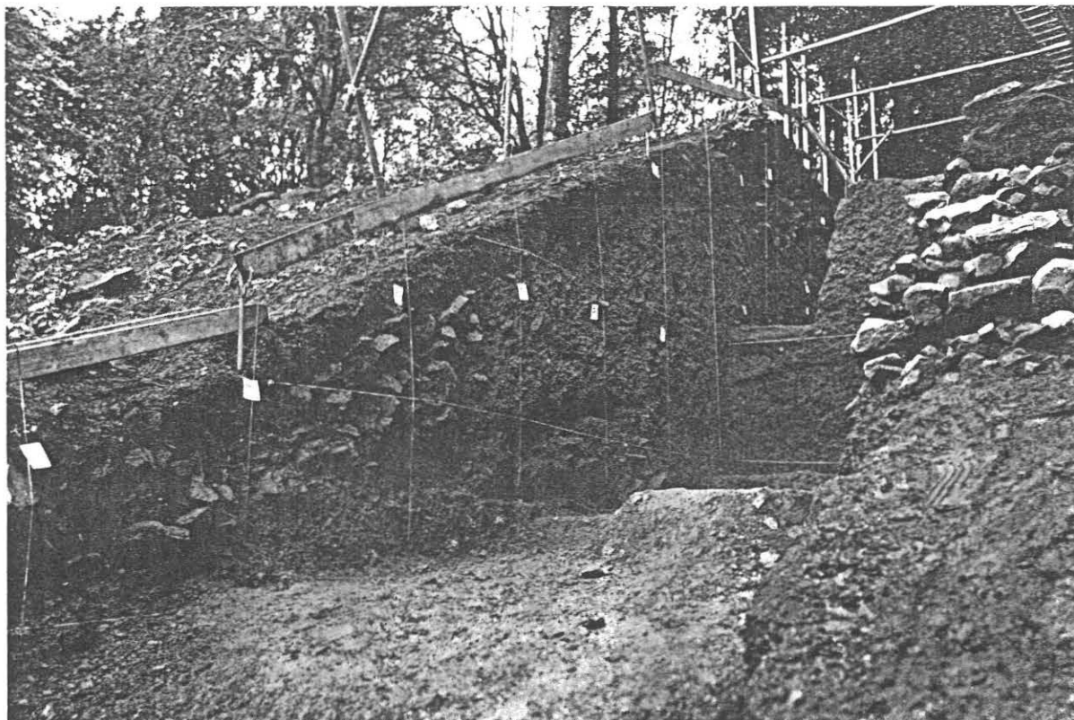
Le murus gallicus à la Porte du Rebout en 1984 ; dans la coupe, trace de poutres horizontales perpendiculaires au parement.
