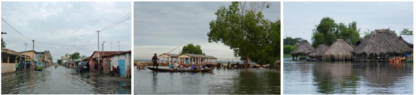
Figure 3 : Inondation de Cotonou, aux abords de la lagune.
