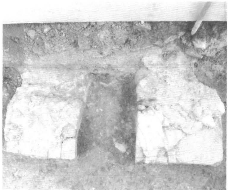
FIG. 15. — Détail des pilettes du premier aménagement de l'hypocauste du local L5 ; vue est. (Cliché IAHA.)
