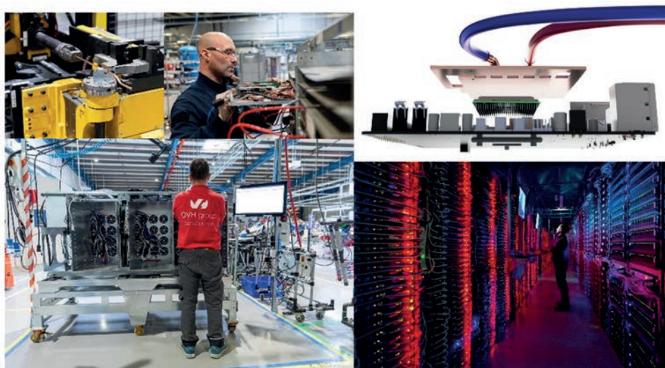
Figure 1. La réalité industrielle derrière le métier de cloud provider
