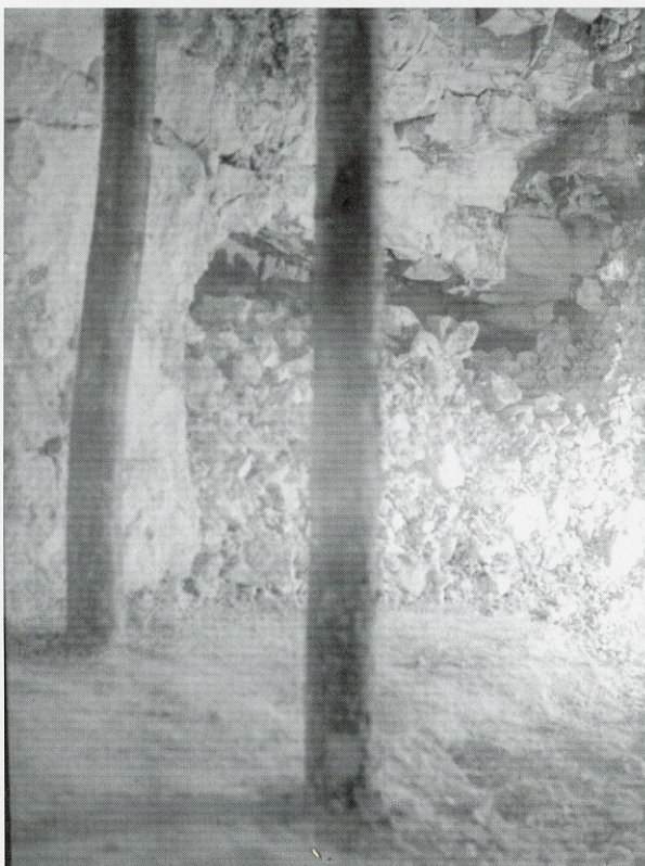
Fig. 59 : Troussencourt (60). 1 - croquis d'une partie des galeries au dos d'une photographie ; 2 - fond de puits avec galerie horizontale non dégagée (obligation d'étayer). Photos H. Lamarre 1938, 1939.
