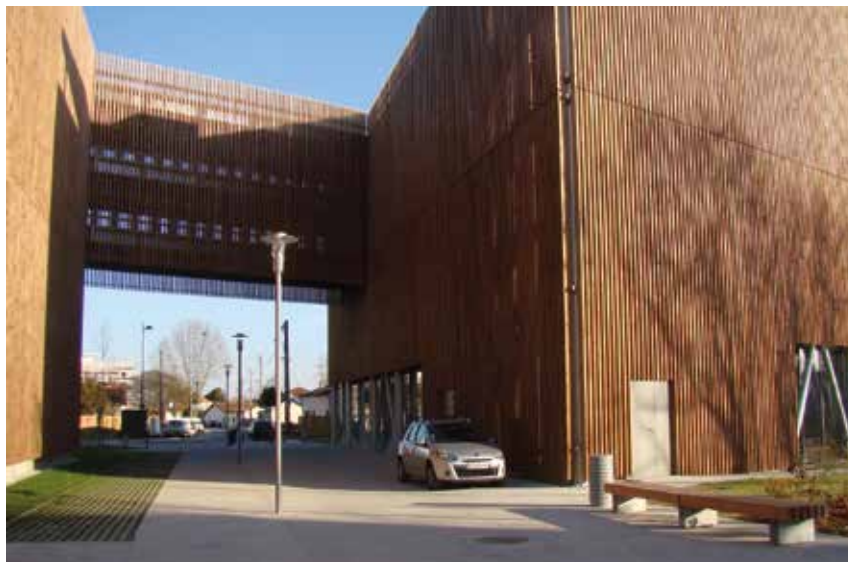
Parking silos au sein d'un écoquartier, écoquartier de Bègles Terres Sud. © a'urba
