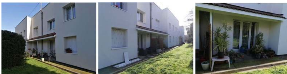
Figure 9. Les redents, servant d'appui pour les appropriations individuelles
