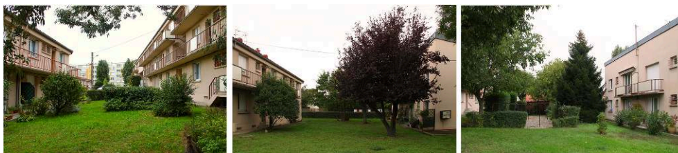
Figure 2. Espaces intermédiaires formés par la disposition du bâti à la cité de l'Hers
